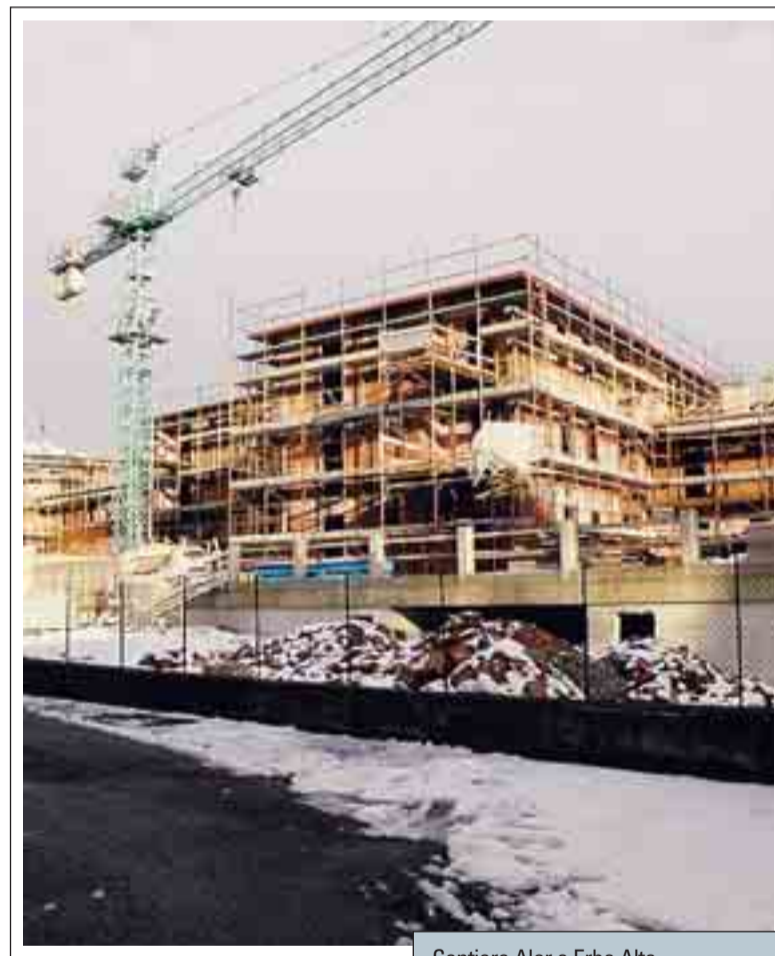
Cantiere Aler a Erba Alta
